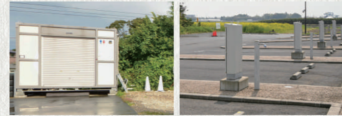
RVパークに設置されているトイレや電源は、災害時に地元のライフラインとしても活用できる。
