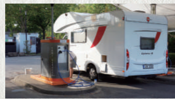
ドライブスルー型のダンプステーション
